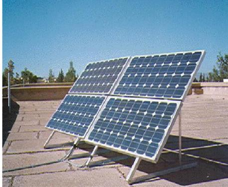
Fig. 11: Panneaux photovoltaïques SP75 installés à la Faculté des Sciences d'Oujda
