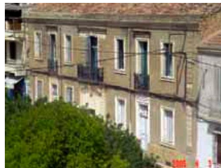
Fig. 2: Façade Sud-ouest (entrée, côté rue) (Source: Auteur)
