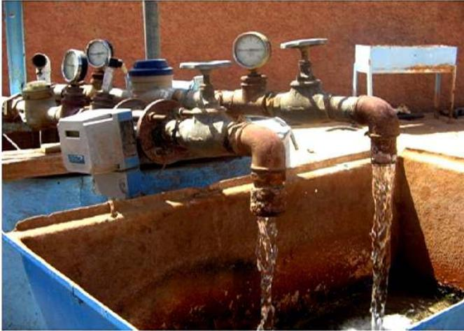
Fig. 2: Puits et instruments de mesure (capteurs de débit, transmetteur pression)
