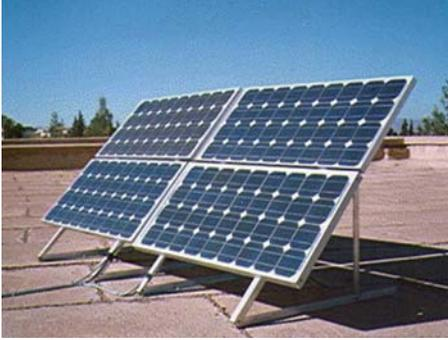
Fig. 3: Modules photovoltaïques SP75 installés à la Faculté des Sciences d'Oujda
