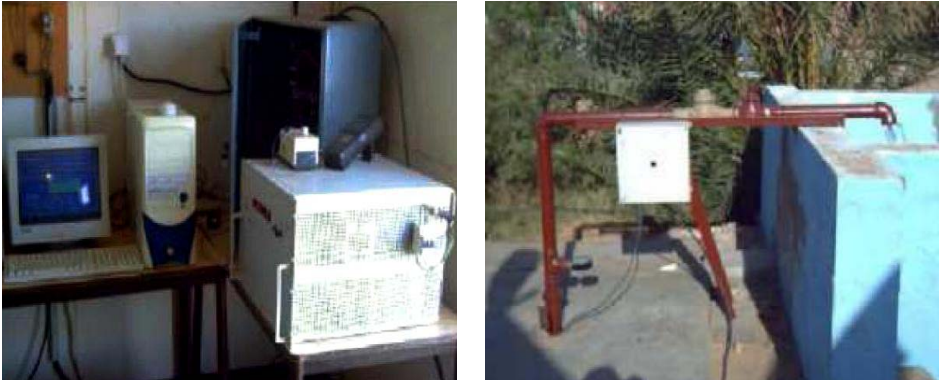
Fig. 1: Vue de la partie électrique et de la partie hydraulique du banc d'essai en fonctionnement
