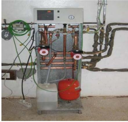
Fig. 2: Module hydraulique de transfert
