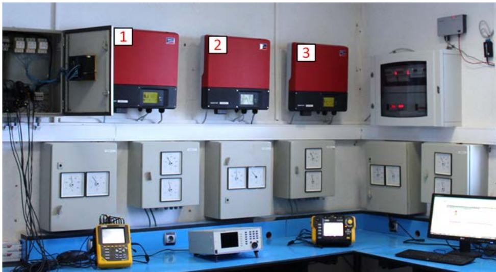
Fig.2. Onduleurs SMA Sunny Boy 3000TL et armoires de protection du système PV connecté au réseau installés au niveau du laboratoire
