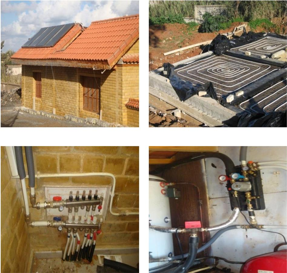
Fig. 2: Eléments du plancher chauffant
