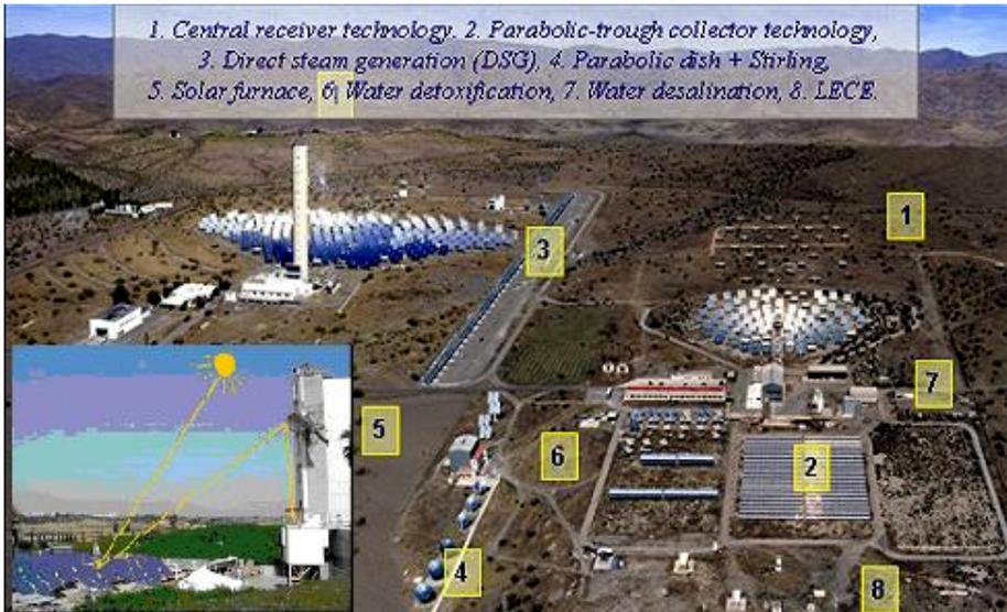
Fig. 9: Installation européenne de la Plataforma Solar de Almería (ES) principal site de tests et de démonstration de l'énergie solaire thermique [35]
