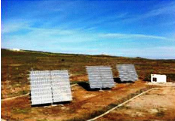
Fig. 1: Panneaux photovoltaïques de concentration 'CPV' installés à l'université Al Akhawayn 'Ifrane'
